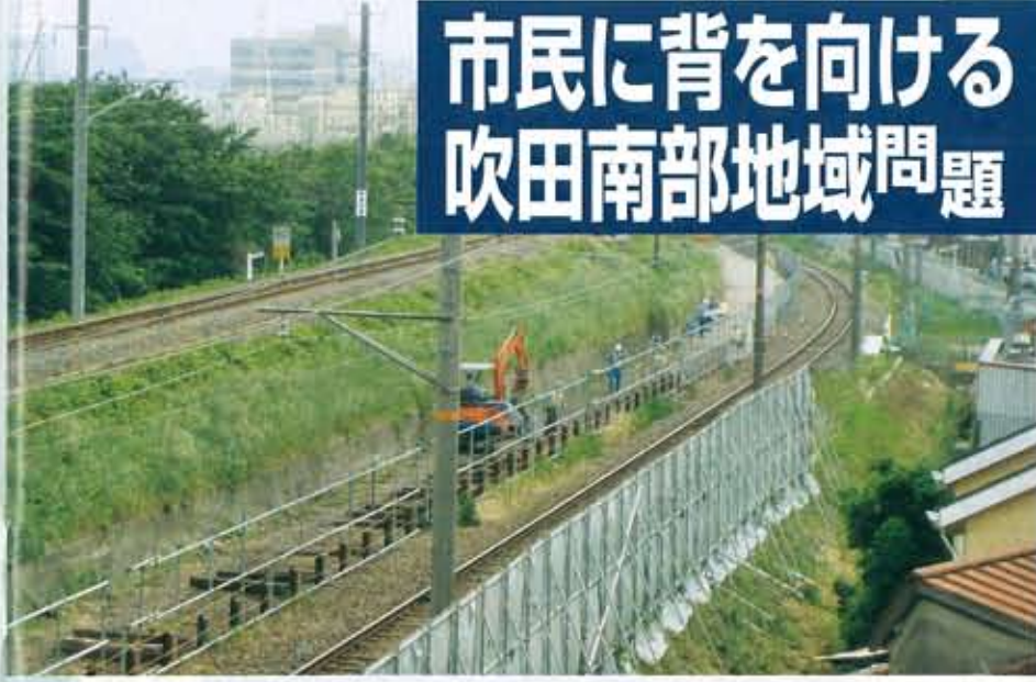
住宅から2本目の線路がはがされ、1本目の線路がその空いた空間に移設される。公害道路は最も住宅に近い所を走る(吹田市泉町)
