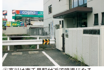
⑨高川は南千里駅付近で暗渠になる
