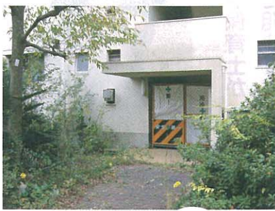
⑦もつれにもつれた桃山台公園団地の建替え
