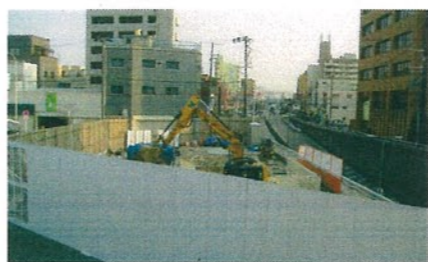
岸辺駅南側でも工事が始まった
